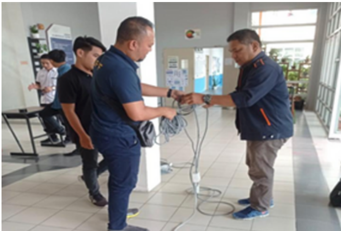
Penyelenggaraan Elektrik di PMU Sepanjang Tahun 2022
