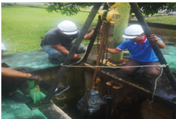
Kerja-Kerja Penyelenggaraan STP Sepanjang Tahun 2022
