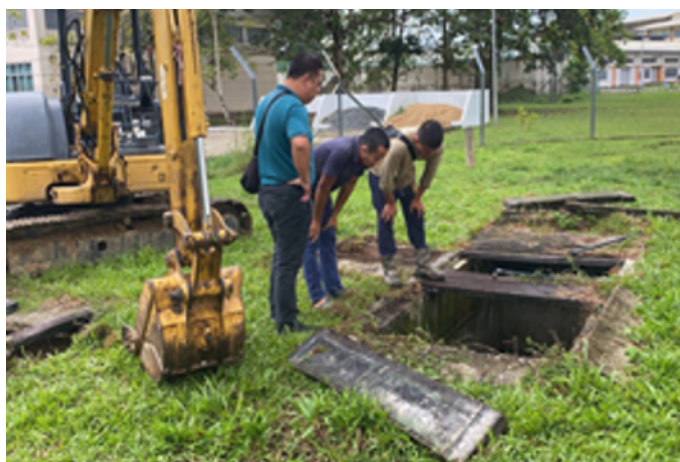
Pembaikan Paip Utama Bocor Di PMU Ogos 2022
